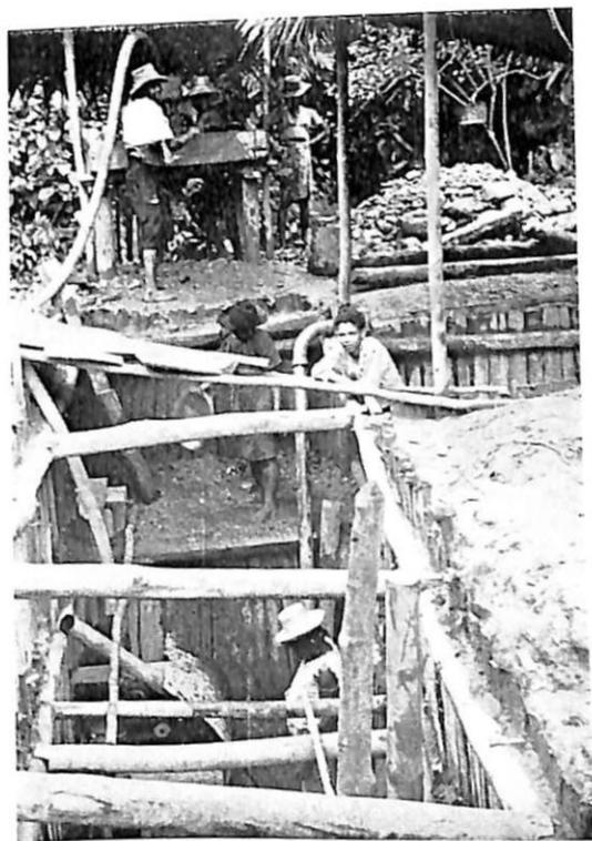
LÁMINA XIV B. Pozos de aluvión en las terrazas arenosas del río Timbiquí, costa del Pacífico. Las paredes son reforzadas con armazones de madera. Las gravas auríferas se extraen con bateas y el pozo se drena con una bomba de gasolina.
