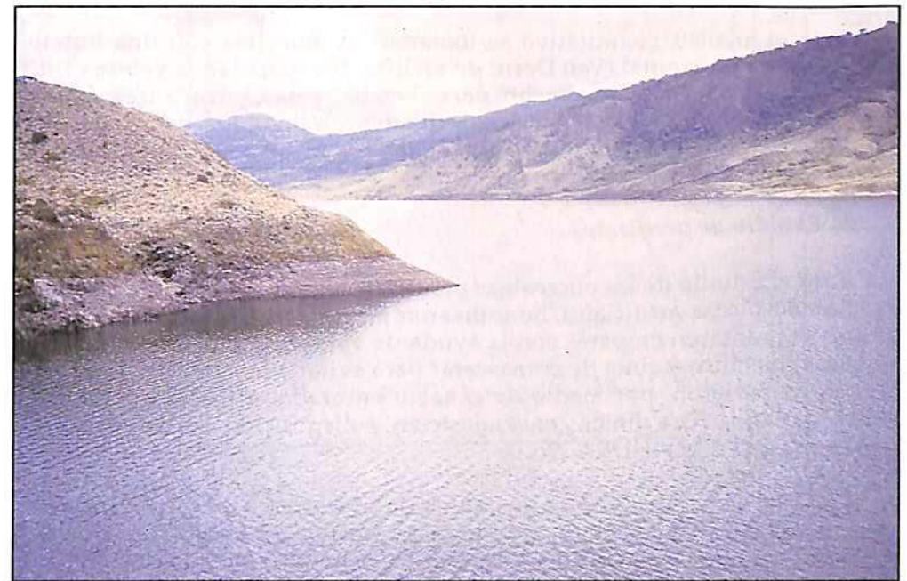
FOTO 6. Estación No. 2. Parte Media o Compuertas en el embalse de Chuza.
